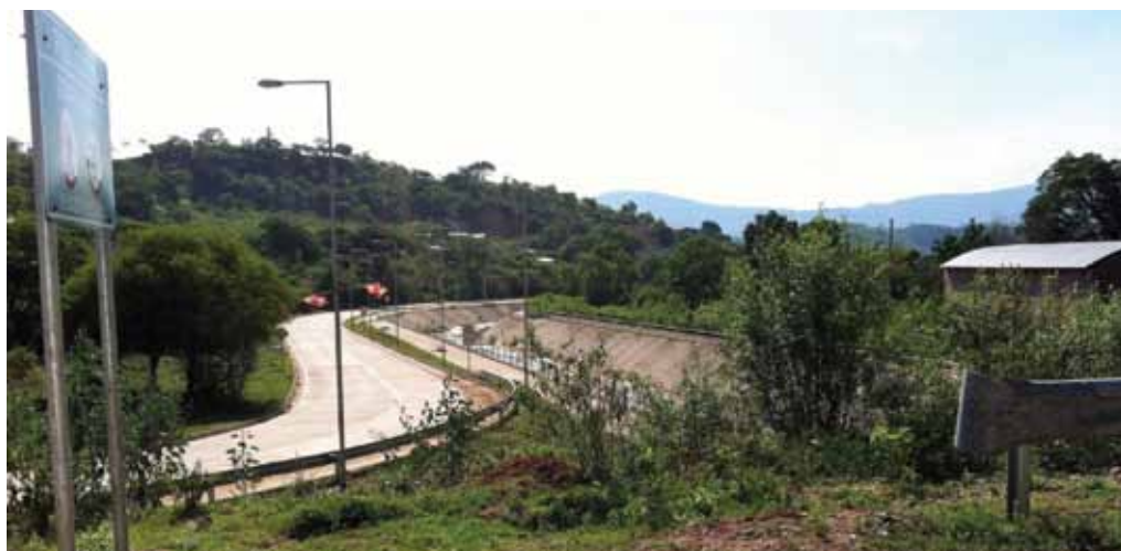
FOTO 2. Quebrada cementada en el pueblo de Caraparí
